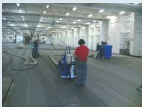
Pallinatura meccanica
