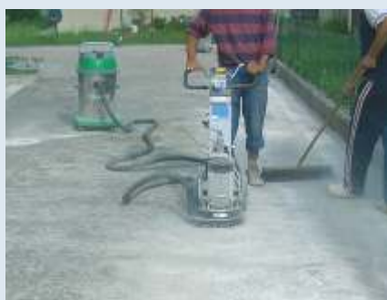
Preparazione al sottosuolo
